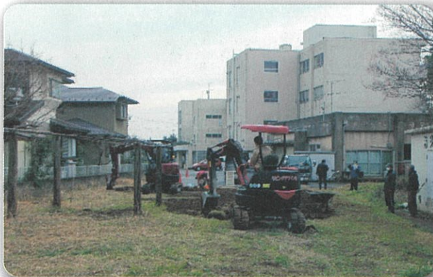
ショベルカー2台で硬い土を掘り起こしました
