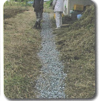
危険箇所である排水溝を砂利で埋めて、完成
